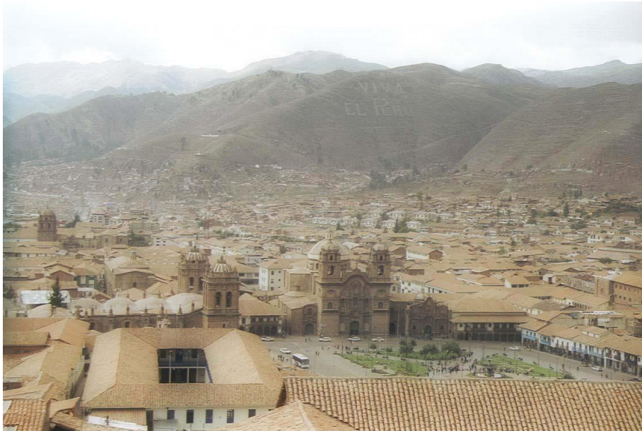
(Fig. 2.25) - Vista do conjunto arquitetônico na atualidade, demonstrando as características da colonização espanhola presente nos dias de hoje. É perceptível a organização através da praça central, além das características arquitetônicas presentes nas quadras. Tais como os pátios internos e a malha em quadrícula. Fonte: http://www.arquiperu.com
