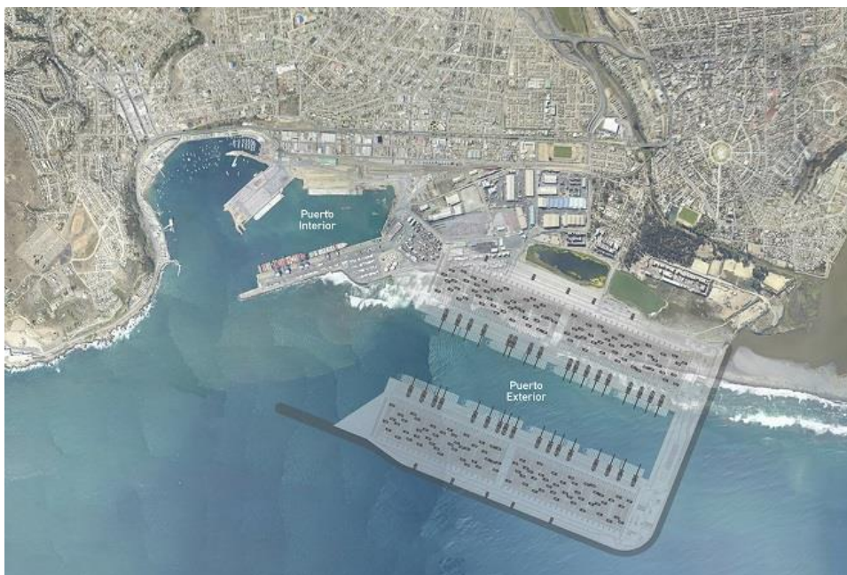
Figura Nº10 Ciudad Puerto San Antonio, Imagen del Nuevo Proyecto de Gran Escala (PGE) , extraída desde: https://portalportuario.cl/puerto-san-antonio-asegura-que-pge-traera-enormes-beneficios-para-el-pais/ , consultado el :2 de diciembre 2018.
