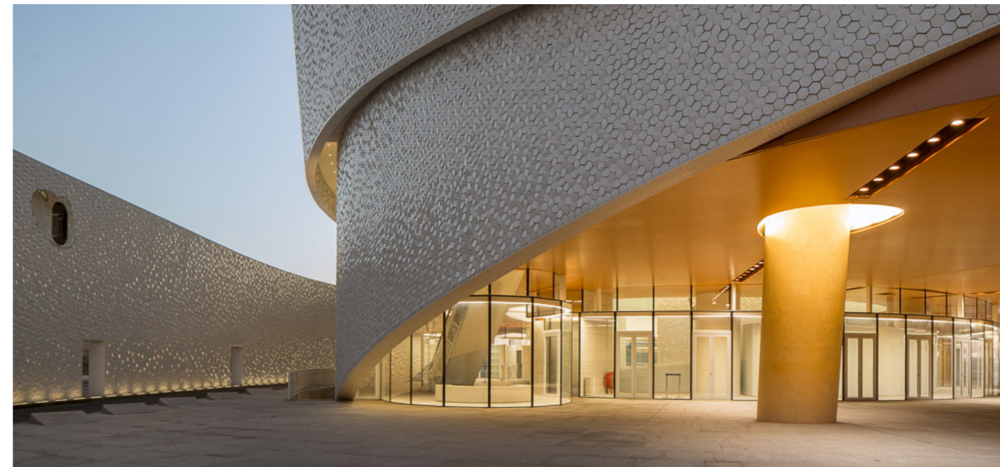
Figura 3.15: Foto do principal acesso no térreo. Fonte: Terminal de Cruzeiros de Leixões / Luís Pedro Silva Arquitecto, Archdaily. Disponível em: https://www.archdaily.com.br/br/779908/terminal-de-cruzeiros-de-leixoes-luis-pedro-silva-arquitecto/568bcbe58ece62ae0004a3-porto-cruise-terminal-luis-pedro-silva-arquitecto-photo?next_project=no . Acesso em 22 set. 2022.
