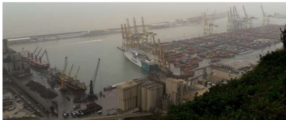
Figura 6.30 – Área nova do porto, terminal de containers.
