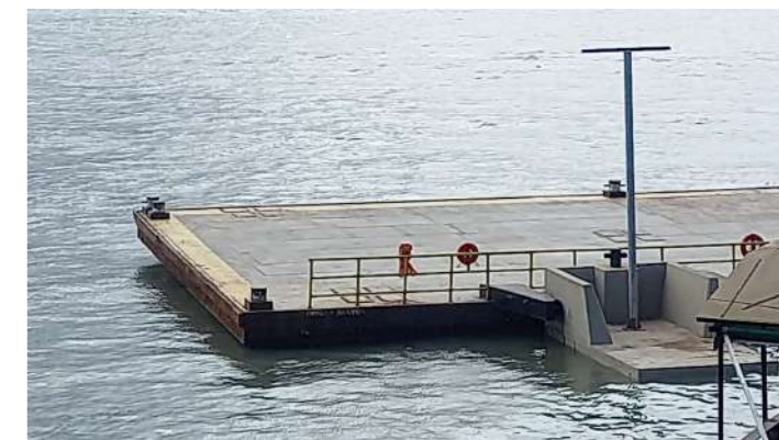
Figura 6.5 – Infraestrutura da Balsa no Guarujá.
