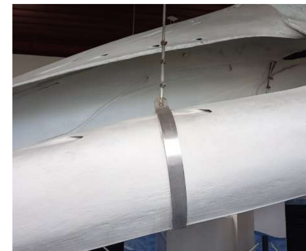
Figura 6.9 – Cabos de aço para a sustentação do esqueleto de baleia no Museu de Pesca em Santos.
