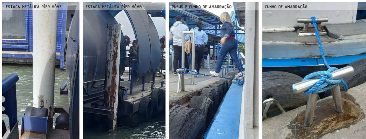
Figura 6.6 – Infraestrutura da Balsa em Santos.
