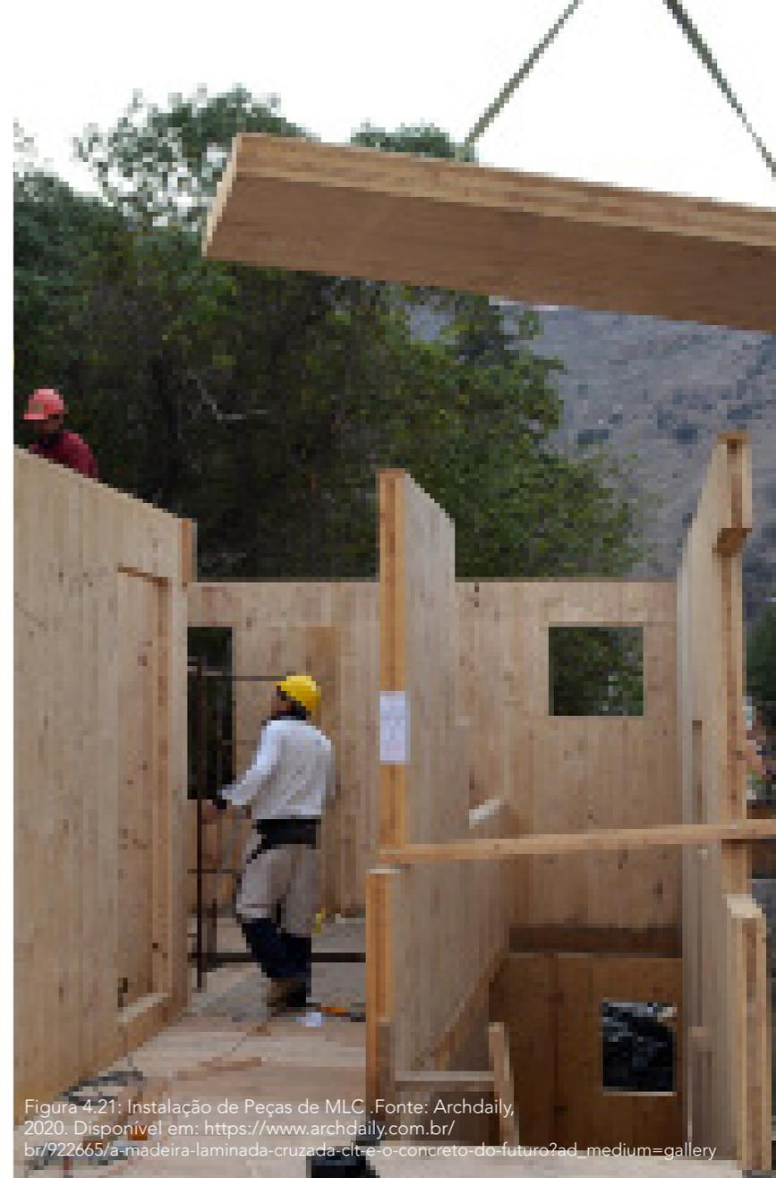
Figura 4.21: Instalação de Peças de MLC .Fonte: Archdaily, 2020. Disponível em: [https://www.archdaily.com.br/922665/a-madeira-laminada-cruzada-clt-e-o-concreto-do-futuro?ad\\_medium=gallery](https://www.archdaily.com.br/922665/a-madeira-laminada-cruzada-clt-e-o-concreto-do-futuro?ad_medium=gallery)
